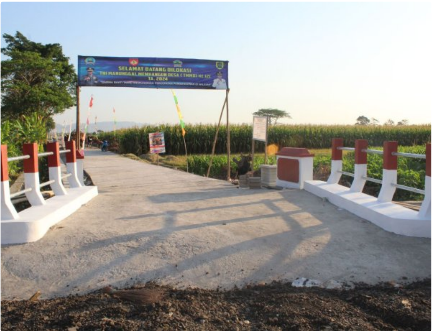
Dandim Klaten Berharap Warga Merawat Jembatan TMMD
